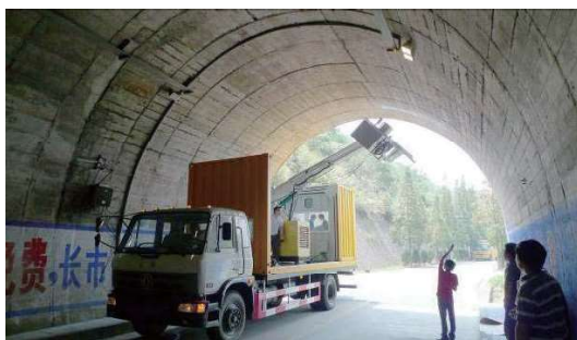
图3 隧道病害集成检测车现场应用
