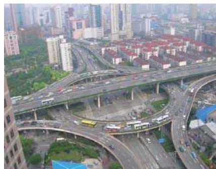
上海市天目路立交环形交叉口
